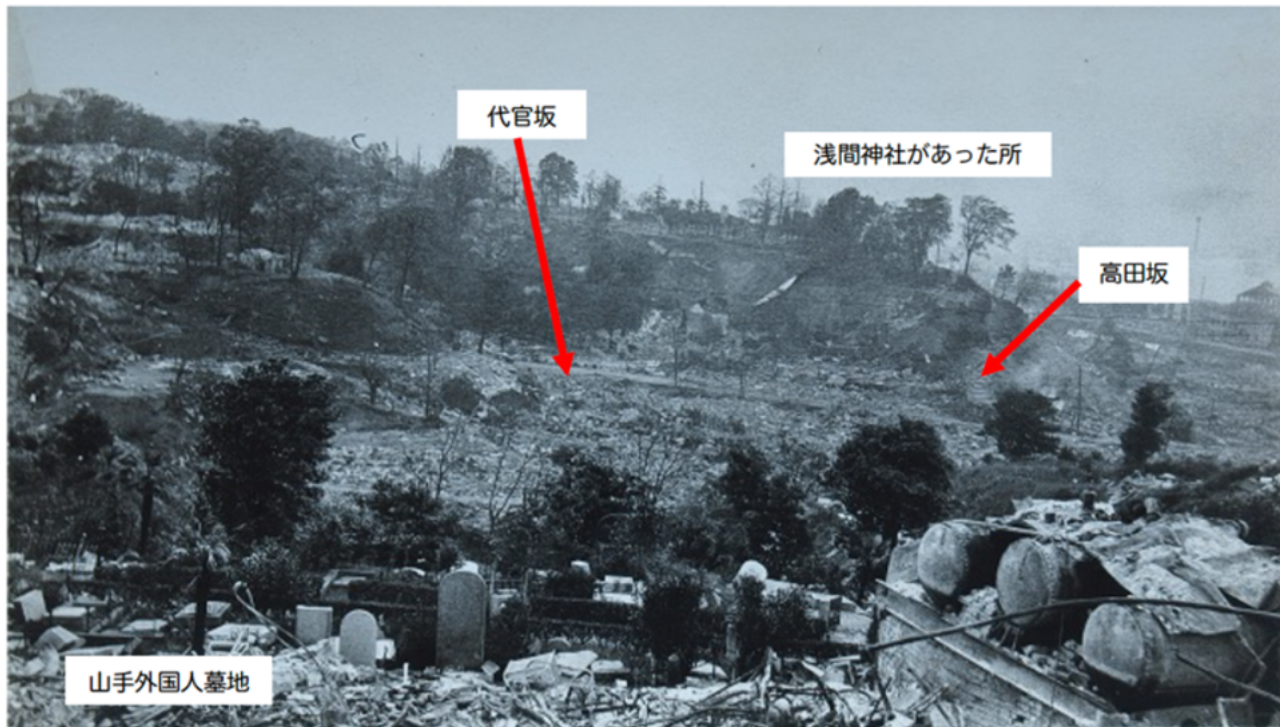
写真 17 震災直後の谷の地すべりのようす (古壁ウォッチング HP より引用)
