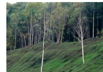
竣工(緑化:風化、浸食防止)
