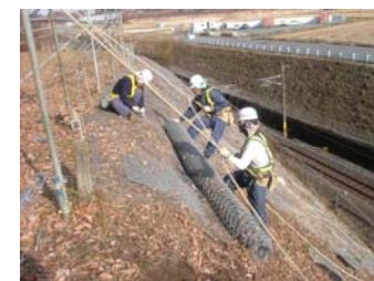
高強度ネット敷設
