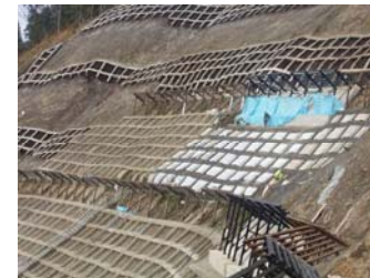
法枠施工状況
