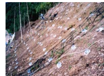
植生基材吹付工
