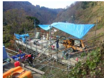
中継点の機械仮設
