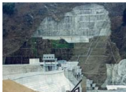
⑧吹付完了後全景
