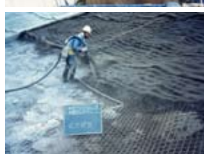
⑤植生基材吹付
