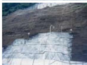
③植生基材吹付
