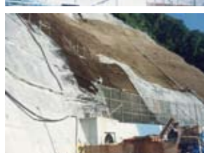
④植生基材吹付
