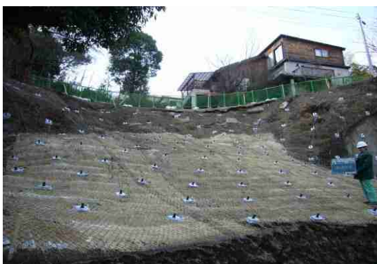
(高強度ネット工+植生マット工)
