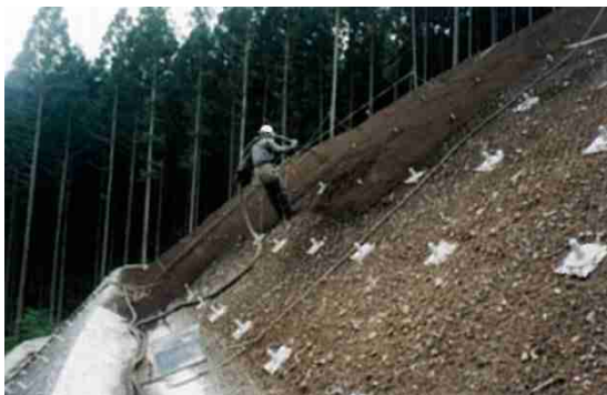
(高強度ネット工+植生基材吹付工)
