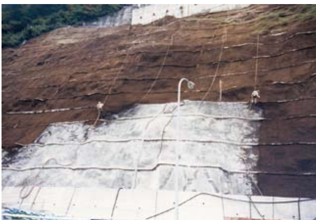
モルタル面の緑化施工状況
