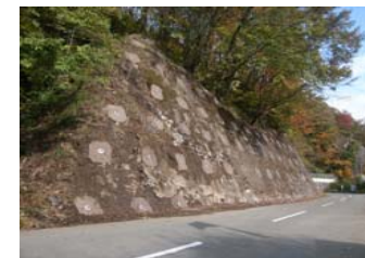
老朽化したモルタル吹付の対策工
