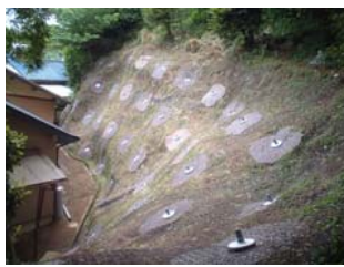
急傾斜地の崩壊対策工 テコネット工
