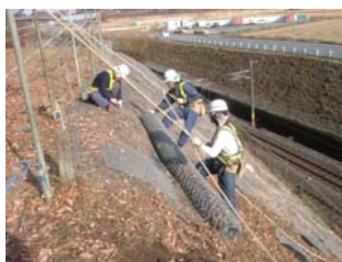
人力による高強度ネットの敷設 TECCOネット
