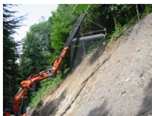
重機による高強度ネットの敷設 TECCOネット
