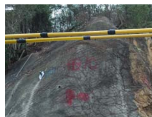
老朽化したモルタル吹付の対策工
