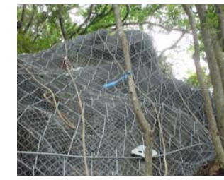
落石などの発生源の安定工 スパイダーネット工
