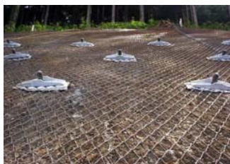
高強度ネットの敷設状況 クモの巣ネット工 クモの巣用プレート
