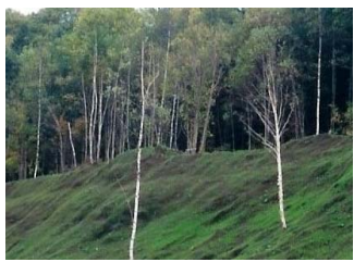
既成法面の災害防除工
