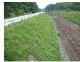
鉄道のり面の安定工
