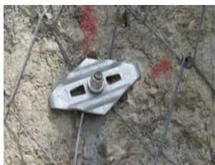
高強度ネットの敷設状況 スパイダーネット工 パワーネット用スパイクプレート
