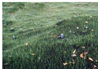
緑化工(植生基材吹付)
